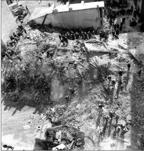
Fig. 5 Morman de moloz rămas în urma prăbușirii blocului Scala situat la intersecția străzii C. A. Rosetti cu bulevardele Nicolae Bălcescu și Gheorghe Magheru
