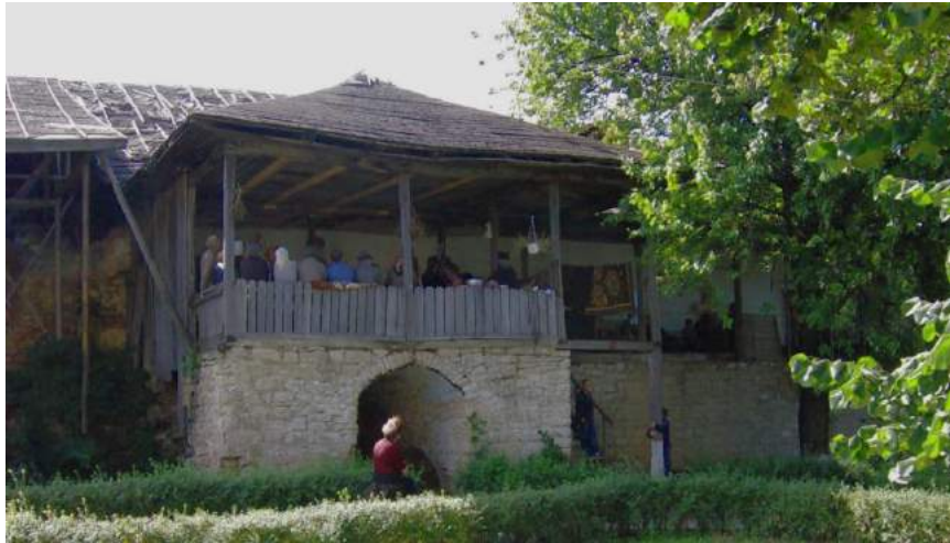
Foto 05-05- Mănăstirea Bârnova. Vedere exterioara Casa Egumenească dinspre Nord (posibil anul 2005).
