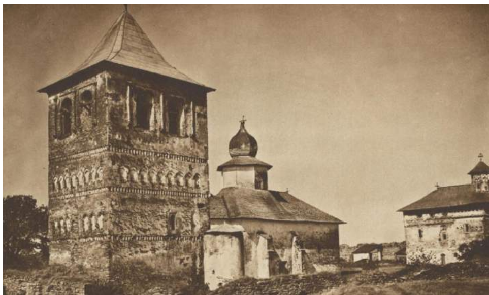
Foto 02-02-Ansamblul Mănăstirii Zamca. Vedere dinspre Nord -Est. (nedată, posibil anii 1920-1925).
