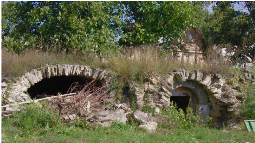
Foto 05-06- Mănăstirea Bârnova. Vedere exterioară a Ruinelor din incintă dinspre Sud (anul 2012).
