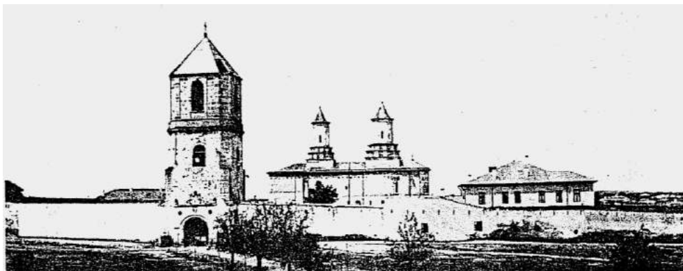
Foto 01-02 - Ansamblul Mănăstirii. Vedere din Sud (nedată, posibil anii 1915-1920).
