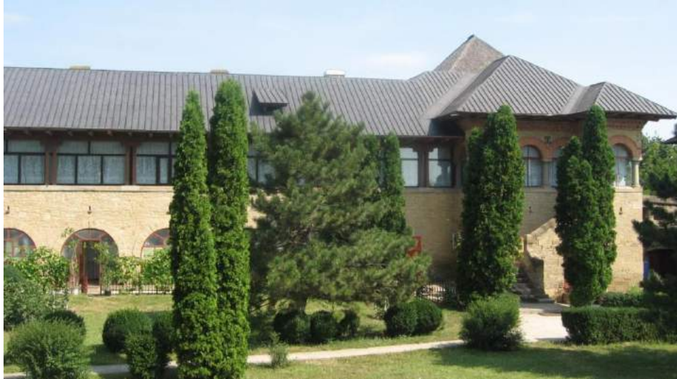
Foto 08-03- Mănăstirea Cetățuia - Sala Gotică. Vedere dinspre Nord (anul 2012).
