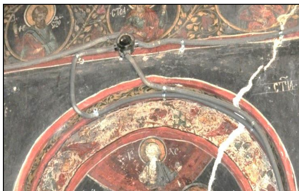
Fig. 5. Conducători electrici prinși în mod necorespunzător de pictura murală
