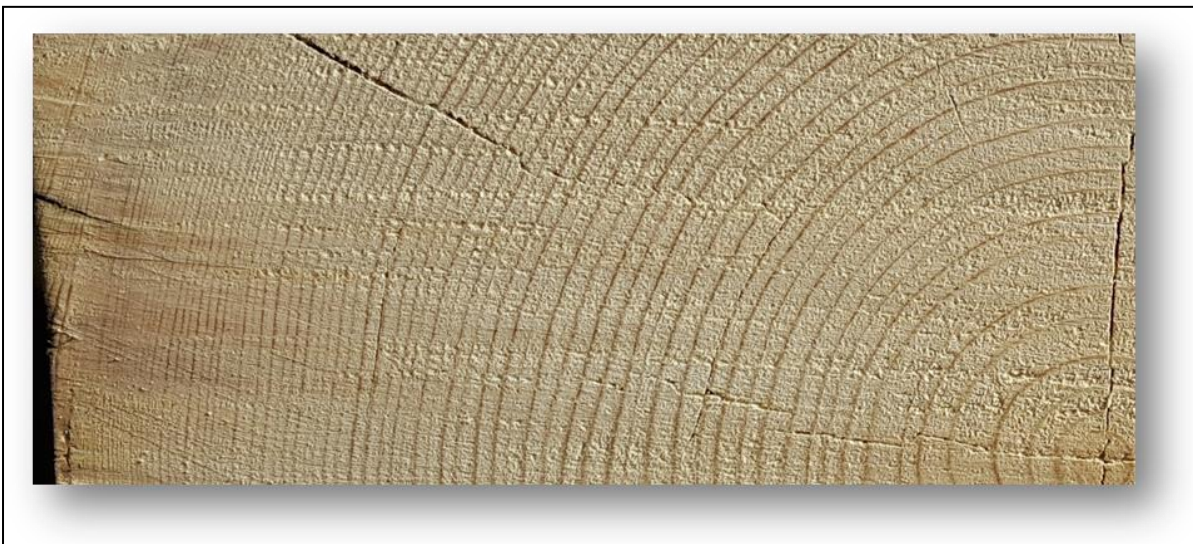
Fig. 7. Secțiune transversală, inele complete. Prelevare dendrocronologică-biserica de lemn, Poiana Stampei
