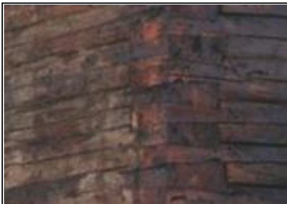
Fig. 5. Bârne pereți-îmbinare coadă de rândunică
