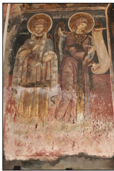
Fig. 9. Efectele umidității de capilaritate - eflorescențe
