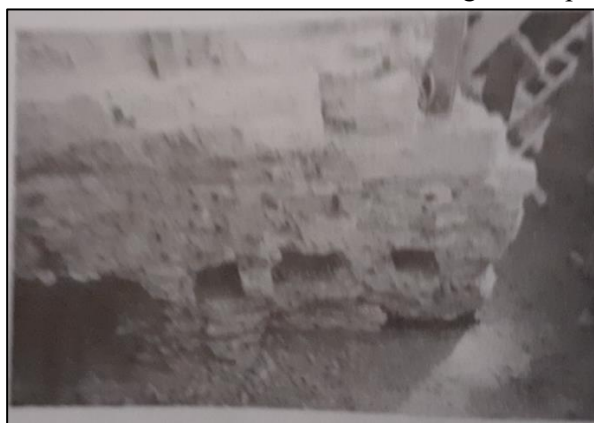
Fig. 10. Peretele vestic al bisericii lui Ioan Golăi unde se observă golurile tiranților.
