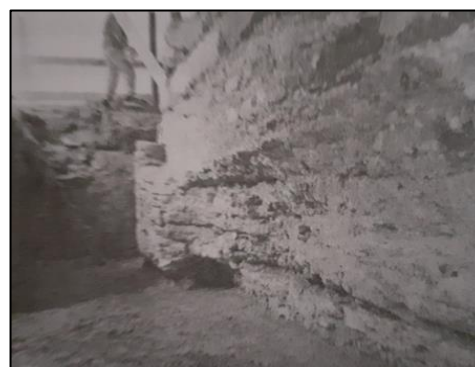
Fig. 13. Plomba executată pe colțul de sud-vest a bisericii actuale; se poate vedea și traseul fundațiilor bisericii anterioare intrând sub biserică.
