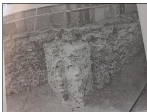
Fig. 12. Plomba executată pe absida de sud-est a altarului bisericii actuale.
