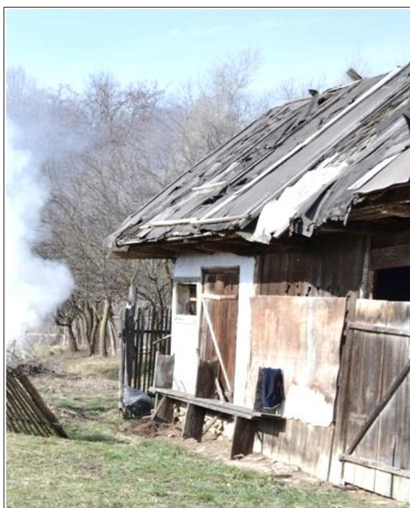
Fig. 5. Al doilea grajd construit pe proprietate, demolat în anul 2018
