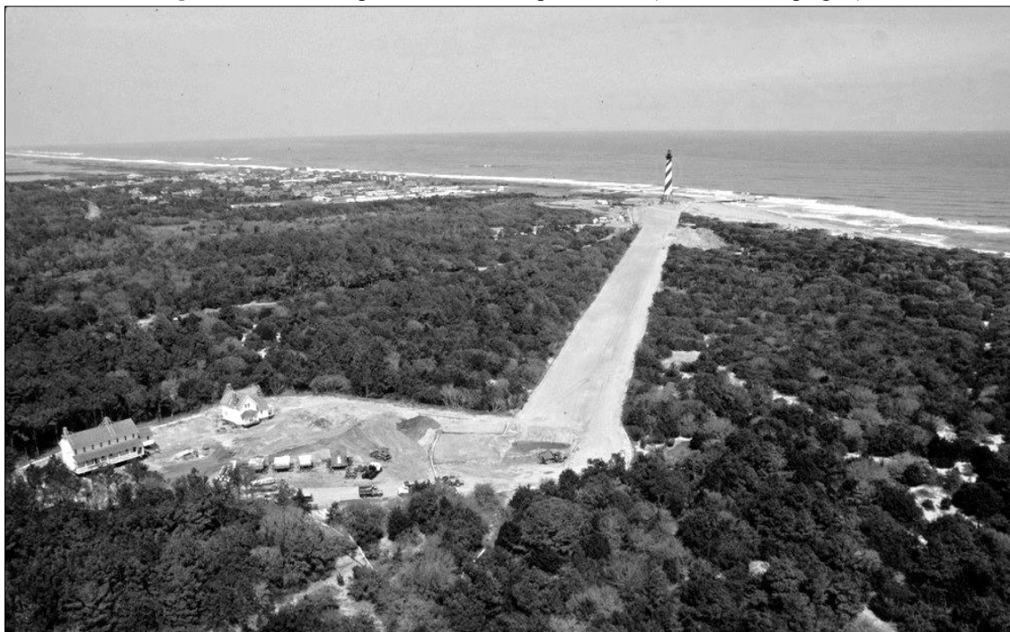
Fig. 4. Farul de la Capul Hatteras și traseul amenajat pentru mutare (Sursa: www.nps.gov )
