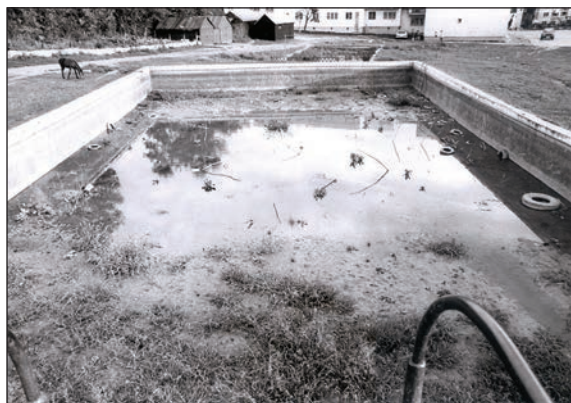
Fig. 16 Fostul bazin de înot / L'ancienne piscine communale
