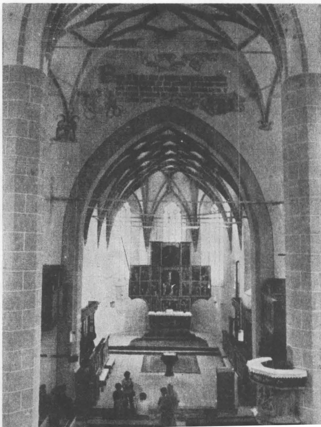
Bolta cu nervuri din corul bisericii în timpul restaurării. În stînga se vede pictura originală decapată în timpul lucrărilor.
