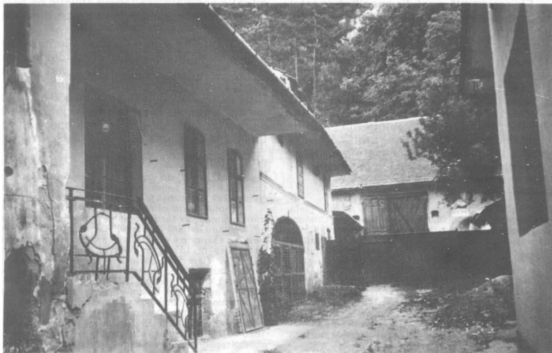
6. Râșnov, Str. Izvorului nr. 4. Locuință, grajd, frână și șură.
