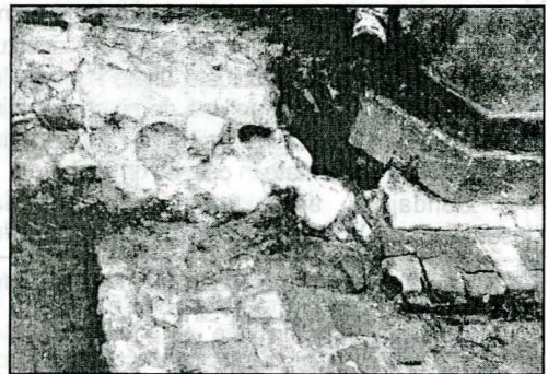
Fig. 7. Fundația laturii de nord a pronaosului și limita estică a blocului masiv de zidărie de cărămidă.
