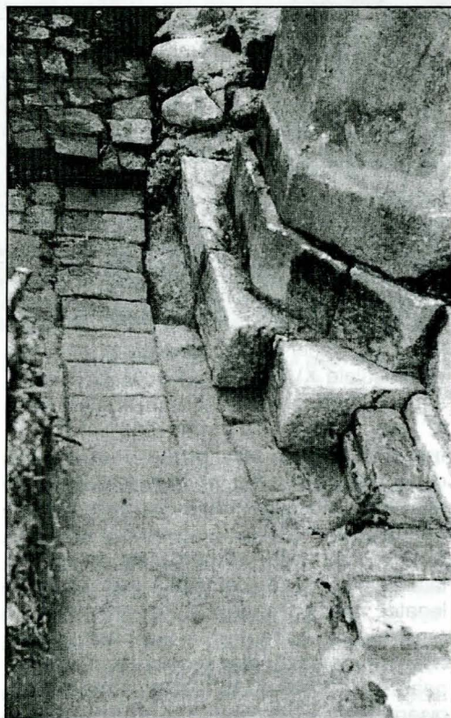
Fig. 10. Fundația pronaosului (colțul de nord-vest) și partea superioară a blocului masiv de zidărie de cărămidă.
