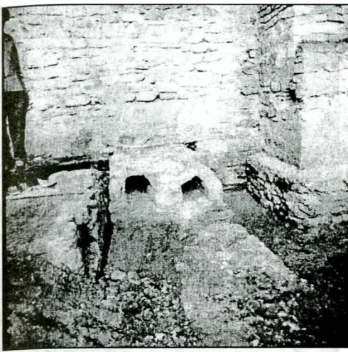
Fig. 6. Sistemul de amplasare a tiranților în fundațiile bisericii 1
