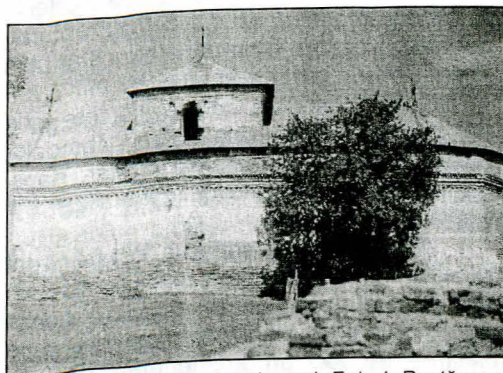
Fig. 2. b. Biserica, fațada sud. Foto I. Postăvaru, 1998
