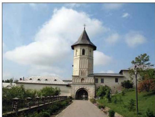
Fig. 9 Mănăstirea Brâncoveni. Accesul
