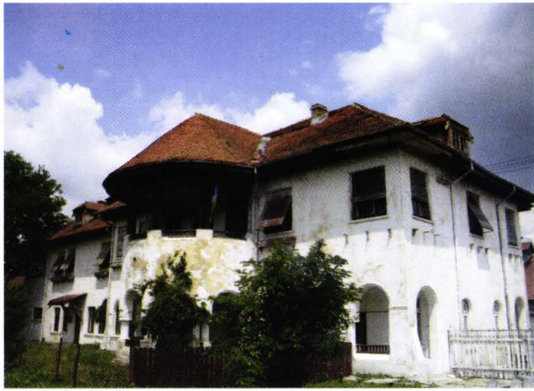
II. 6. „Conacul Voinea“, Băneasa, ansamblu de 8 clădiri, jud. Giurgiu
