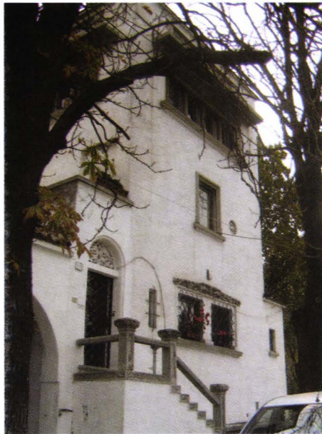
26. Vila „arh.Gh. Simotta”, aleea Dealul Mitropoliei nr. 15, arh. Gh. Simotta - Fațadă principal spre aleea Dealul Mitropoliei
