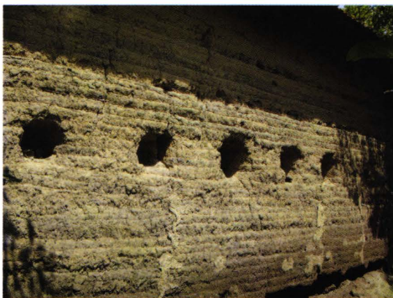
II. 4. Construcție din pământ „bătut” în cofraj. „Casa Răducu Filip”, sat Seaca, jud. Teleorman
