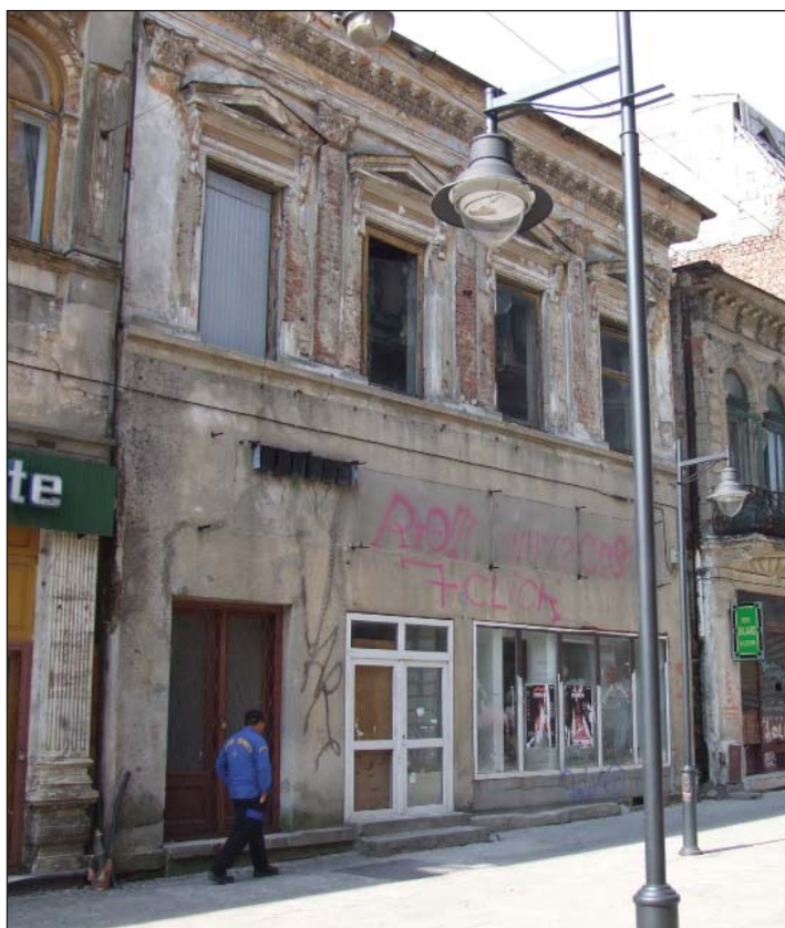
Fig. 32. Casa de pe strada Franceză 40 - Fațada dinspre strada Carol I
