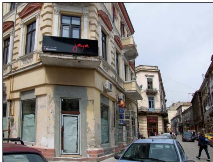
Fig. 6 - "Restaurări" neprofesioniste executate de meșteri
