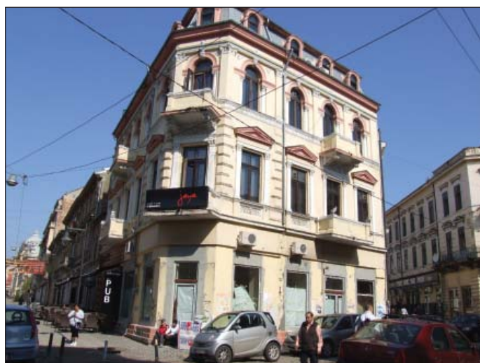
Fig. 9 - Restaurarea încă nu s-a terminat,...
