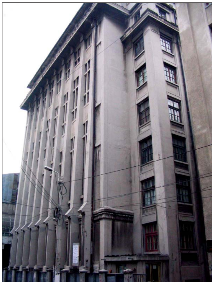
Fig. 2 – Corpul amfiteatrelor – fațada la str. Stanislas Cihoschi
