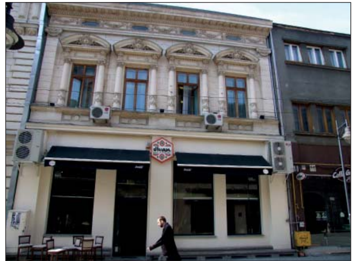
Fig. 27 - Exemplu de restaurare decentă și unitară
