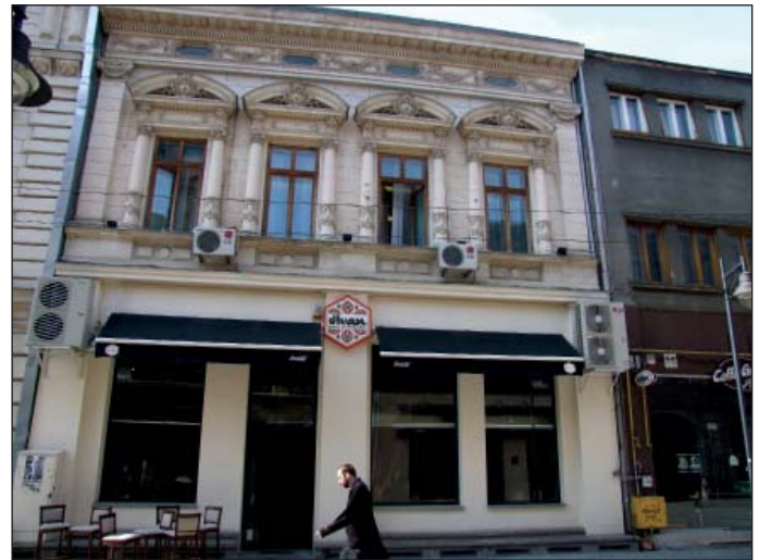
Fig. 27 - Exemplu de restaurare decentă și unitară
