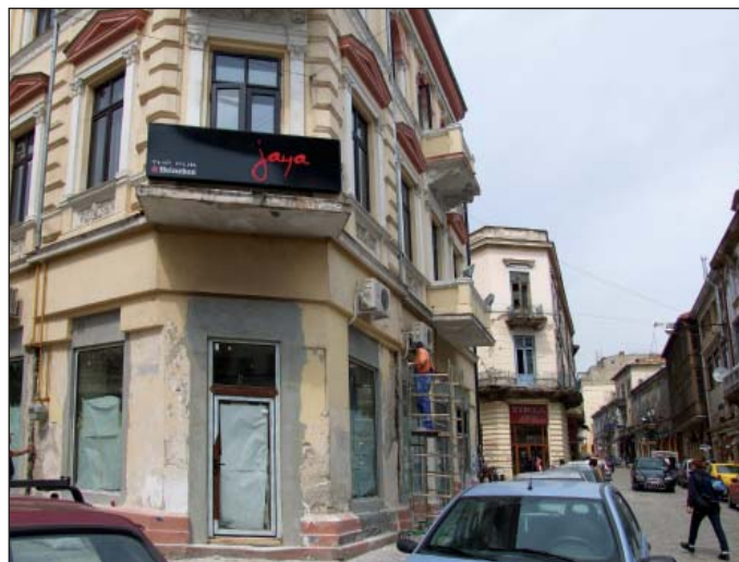
Fig. 6 - "Restaurări" neprofesioniste executate de meșteri
