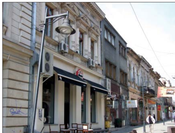
Fig. 3 - Exemplu de “degradări estetice”
