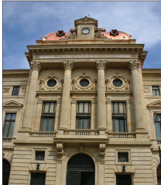
Fig. 33 - Zona centrală a fațadei Lipscani, (a) înainte, (b) după intervenție / Middle part of Lipscani facade (detail). National Bank of Romania, (a) before, (b) after intervention.
