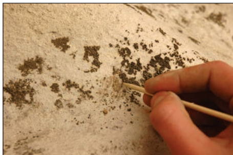
Fig. 16 - Îndepărtarea manuală a biocrustei, fațada Lipscani / Manual removal of biocrusts., the Lipscani facade.
