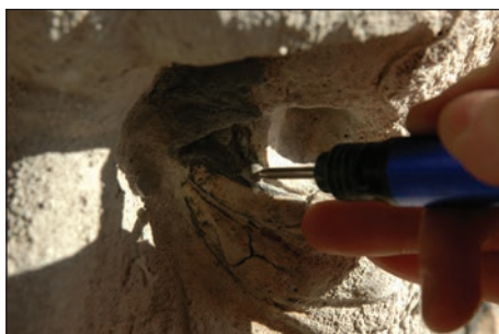
Fig. 17 - Îndepărtarea manuală a crustelor minerale consistente cu ajutorul frezelor stomatologice, fațada Lipscani / Manual removal of the consistent mineral crusts using stomatologic drills, the Lipscani facade.
