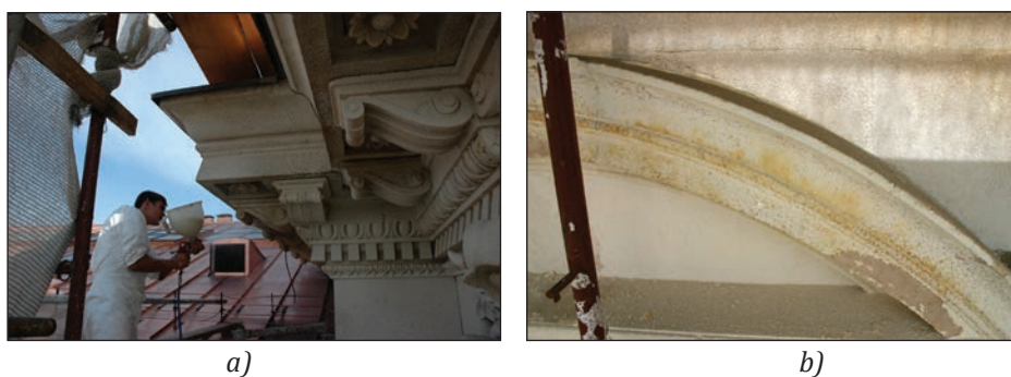
Fig. 18 - Extragerea sărurilor solubile prin comprese: aplicarea compresei prin pulverizare (a); detaliu al unei suprafețe cu compresa uscată, salinizată, înainte de îndepărtare (b). Suprafața de calcar după îndepărtarea compresei, fațada Lipscani / Extraction of soluble salts by compresses: compress application by spraying (a) detail of dry surface of the salinated compress before removal. (b). The limestone surface after compress removal, Lipscani facade.
