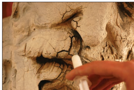
Fig. 20 - Zone de calcar friabil și fisurat care au necesitat consolidarea suportului, înainte de colmatarea fisurilor, prin impregnarea soluției consolidante: (a) prin pulverizare; (b) prin pensulare; (c) prin injectarea consolidantului în fisurile din rocă, fațada Lipscani / Brittle and cracked limestone areas that required consolidation of the support, before clogging the cracks, by impregnating of the consolidated solution: (a) by spraying, (b) by brushing, (c) by injection of the consolidated solution into the rock fissures, the Lipscani facade.
