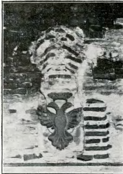
10. Consolă, cu stema Cantacuzinilor. (Susținând capetele arcurilor bolților, în saloanele Domnului din Palat).
