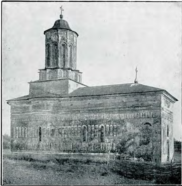
1. Biserica mănăstirii Aron-Vodă — Înaintea lucrărilor din 1907 —
