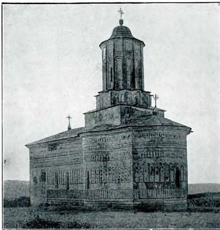
2. Biserica mănăstirii Aron-Vodă — Înaintea lucrărilor din 1907 —
