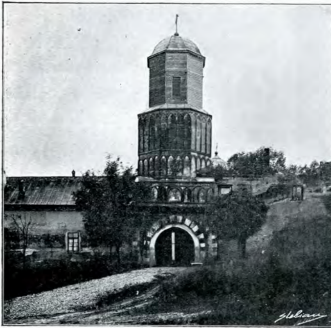
Turnul-clopotniță dela Mănăstirea Brâncovenii. — Epoca Matei Vodă. —
