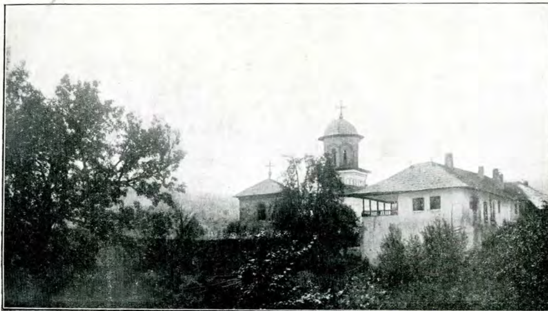
1. Vedere generală, spre intrare.
