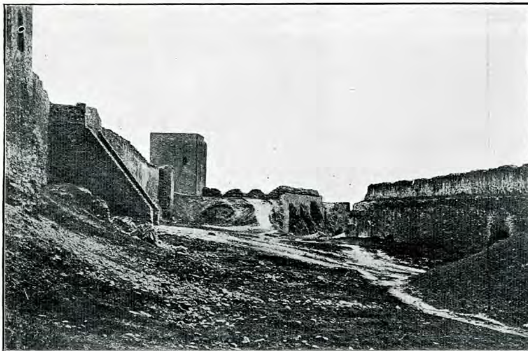
Fig. 1. Vedere în interiorul curții celei mari (jumătatea despre vest) a Cetății Albe.
