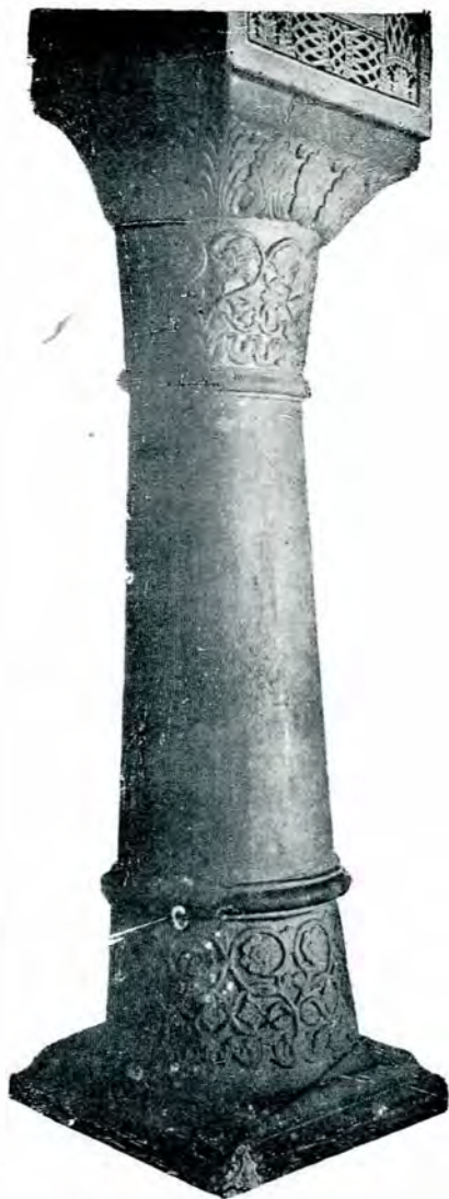
12. Coloană din «sala de piatră» a stăreției.
