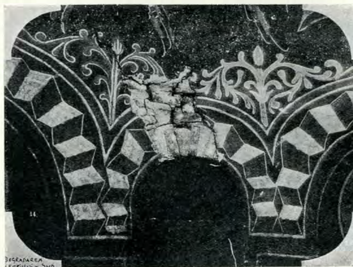
Fig. 107 Degradări interioare în nișele turlei, dintre ferestre.
