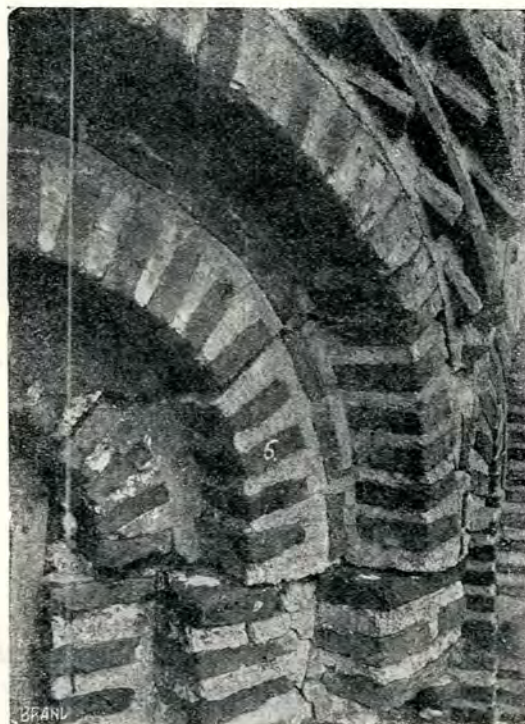
Fig. 104. Degradări în fereastra de est a turlei.
