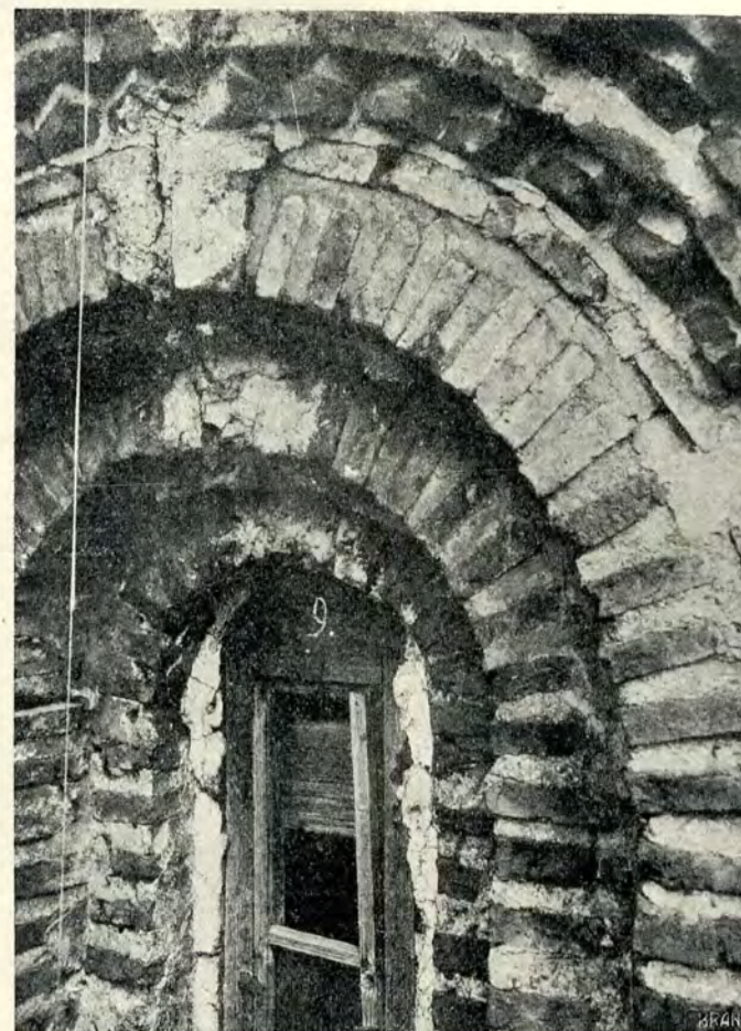
Fig. 101. Degradări în fereastra de sud a turlei.
