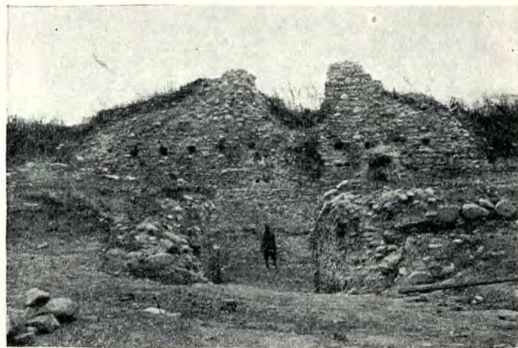
Fig. 138. Ruinele Casei Domnești, la terminarea săpăturilor, 1921.
