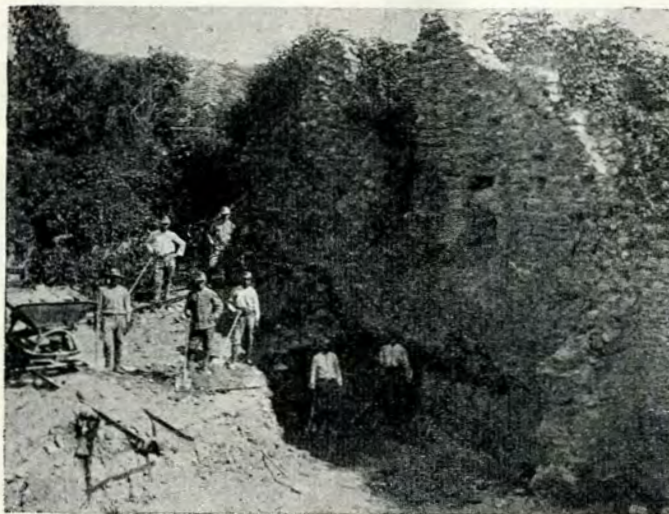
Fig. 150. Pivnița Casei Domnești în timpul săpăturilor.
