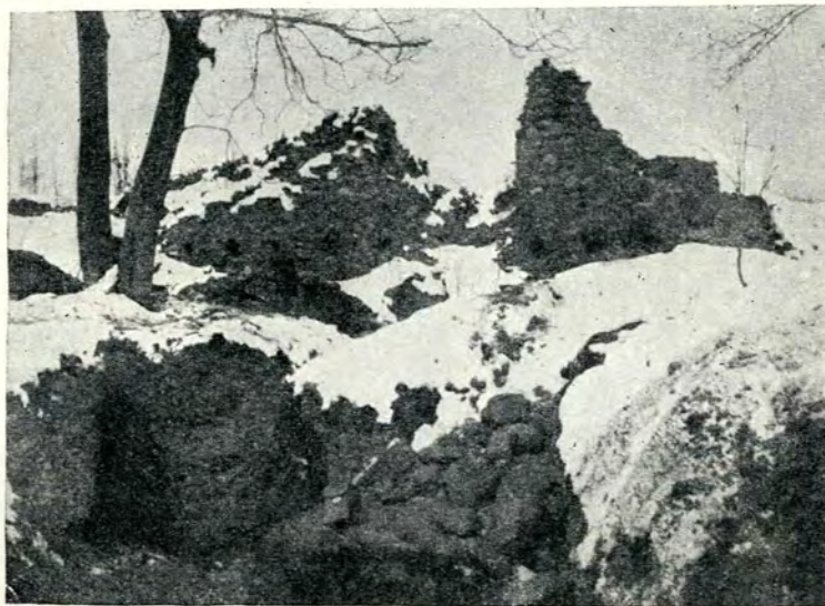
Fig. 136. Ruinele Casei Domnești în timpul săpăturilor; Noemvrie 1920.
