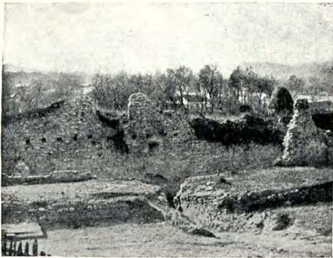
Fig. 137. Ruinele Casei Domnești, la terminarea săpăturilor, 1921.
