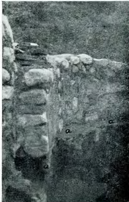
Fig. 13. — În laturea de Nord a altarului, cu retragerea zidului spre naos: a, locul grinzii catapetesmei și pardoseala Bisericii a II-a.
