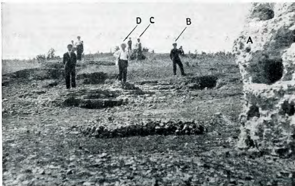
Fig. 14 – Ruinele capătului sudic al podului lui Traian: A, pila culeei; B, C, D, fundațiile pilelor dintre culee și portal.
