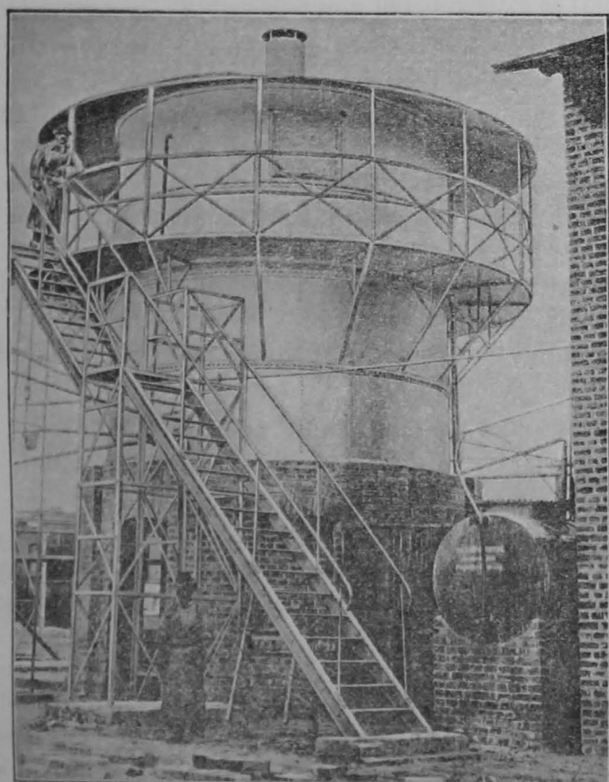
Fig. 7. — Turnul pentru tratat petrolul, cu acid sulfuric, de la Satul Noiu.
