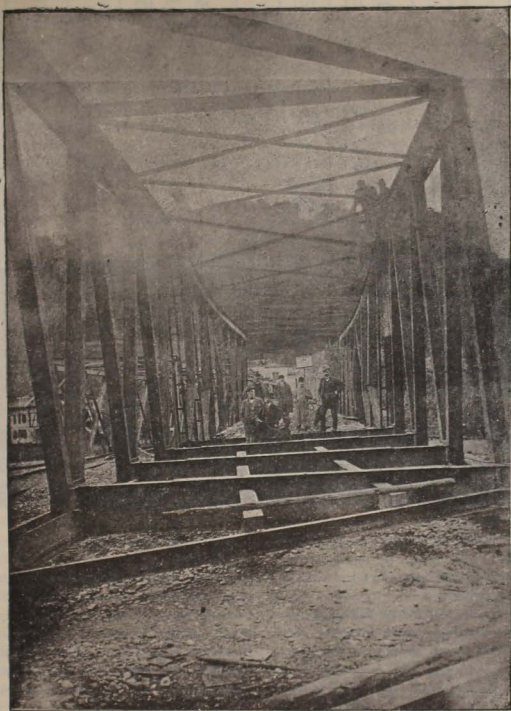
Incercarea la rupură a unui pod de fer. — Vedere, în față, după rupere.
