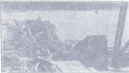
Căderea podului dela Québec.
