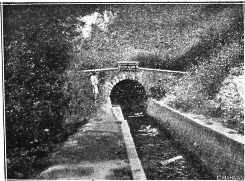
Fig. 32. — Capătul aval al tunelului Teiuș.
