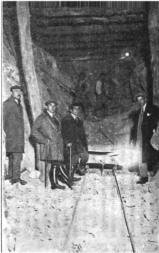
Inceputul executării abatajului strosului și vederea susținerilor la tunelul Leurzeaua
