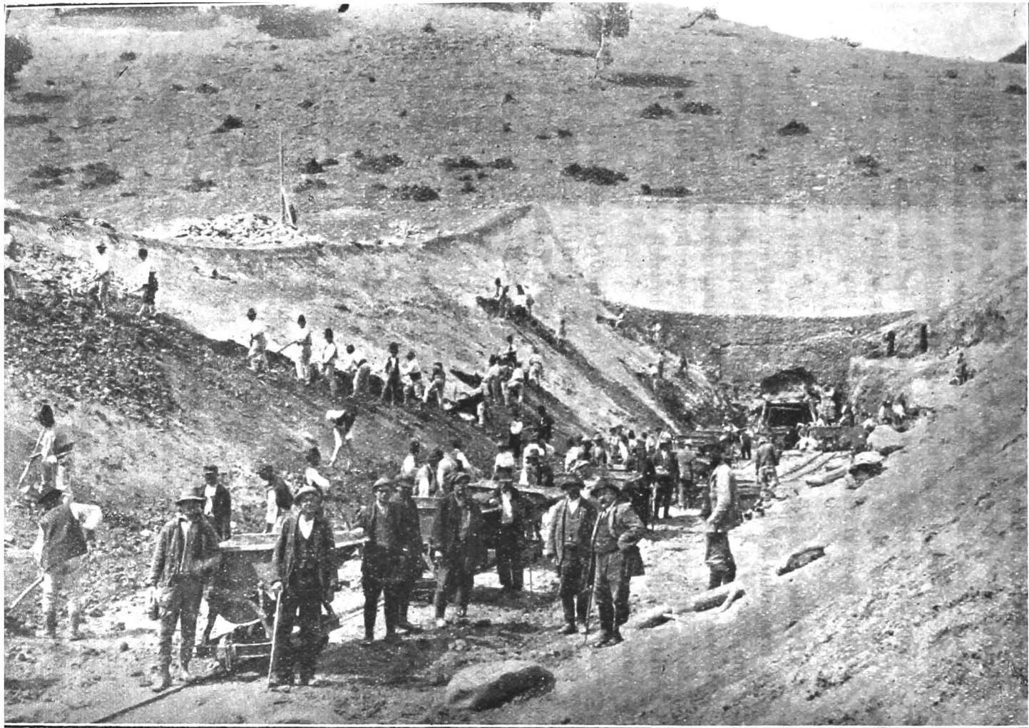
Executarea terasamentelor tranșei aval a tunelului Ploșca și atacarea galerii de avansare. km. 375+700—375+808.
