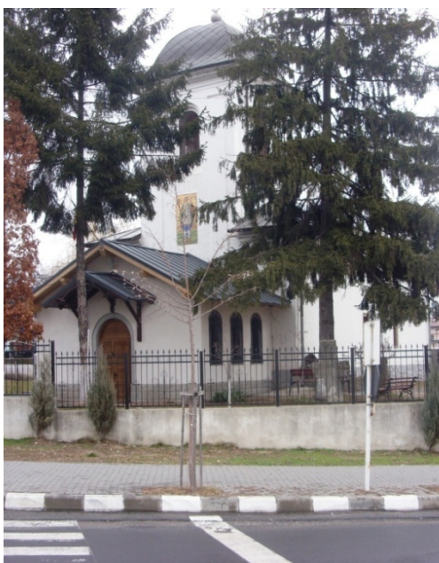
După terminarea lucrărilor
