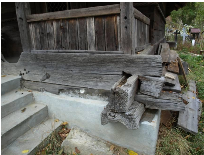
Foto 2. Aspect grinda talpă / Main wooden beam.
