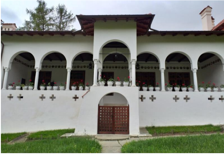
Logia (construită 1937 -1939; piatră de moară, poartă din stejar cu tiranți, coloane din piatră de Baschioi)
