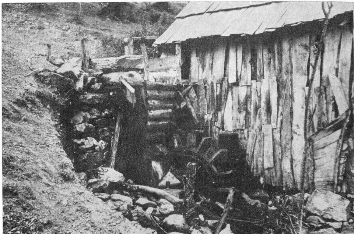
Fig. 8. Roată cu aripi și sistemul de punere în func- țiune al pivelor de pe valea Bahnei.
