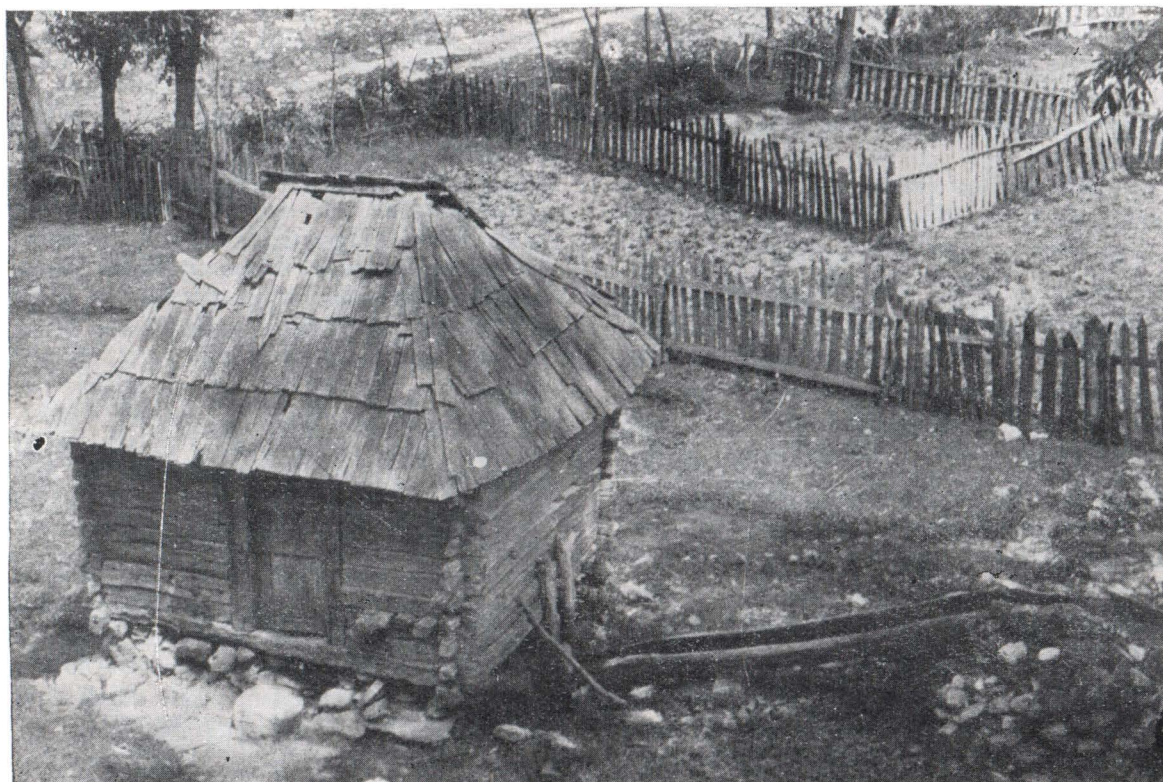
Fig. 3. Moară cu ciutură cu dig și jgheab de lemn fix.
