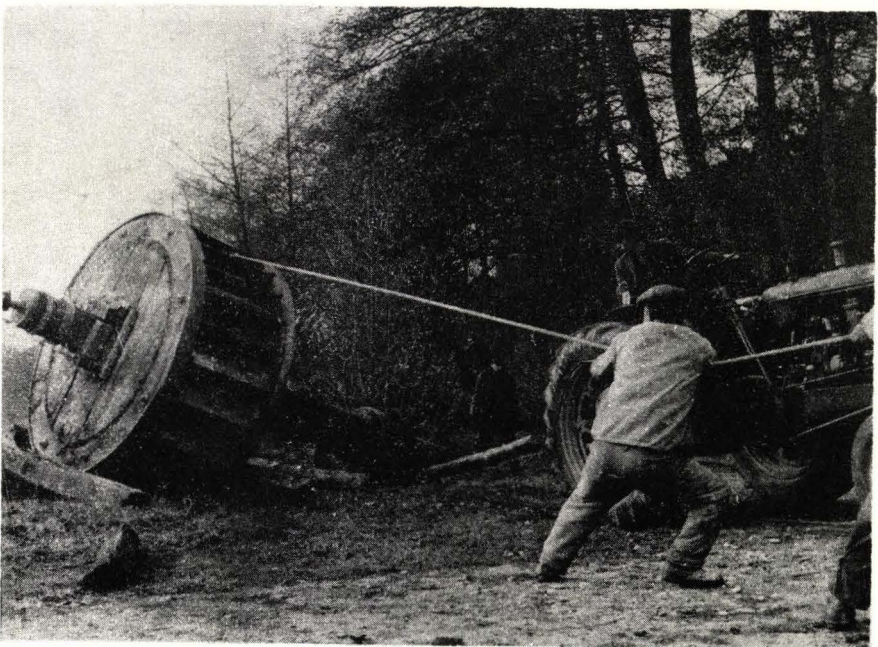
Fig. 4. Lucrări la remontarea ciocanului hidraulic de la Remetea jud. Alba (expus în Muzeul Tehnicii Populare — Sibiu, în anii 1969—70).
