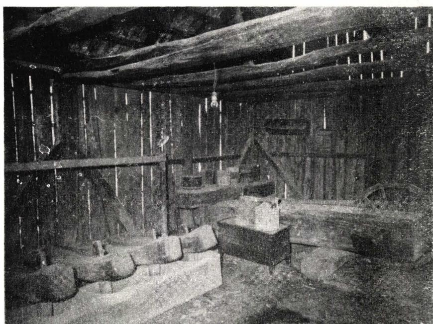
Fig. 5. Interiorul uleiniței din com. Nădăjta, jud. Hunedoara: O parte din ciocane și teascul cu roată verticală.
