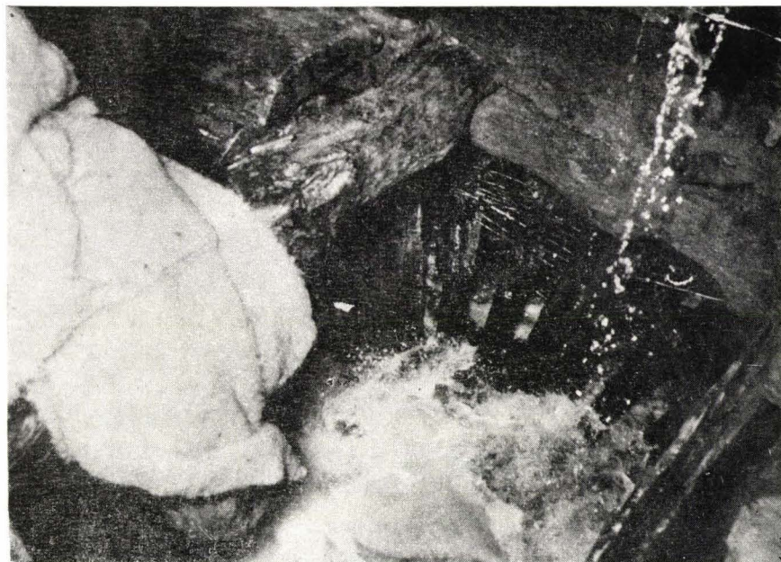
Abb. 9. Wirbelkorb der Walkmühle aus Prigor (Blick aus dem Innern des Gebäudes nach unten).
