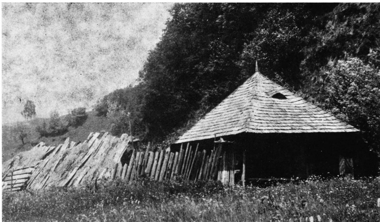
Fig. 4. Gospodărie de finațe — Sătic — Rucăr. Vedere „in situ“
