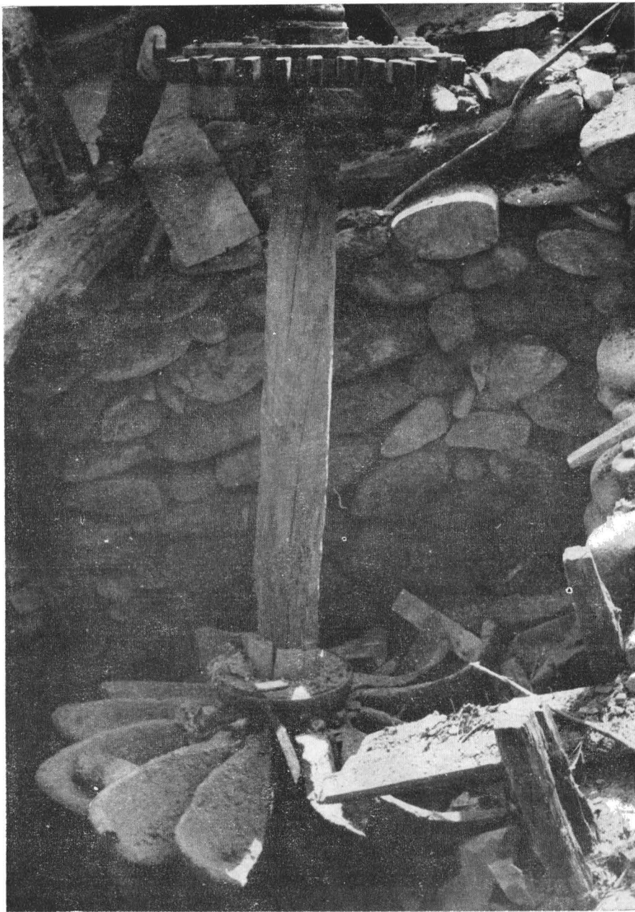
Figura 5. Instalația morii cu ciutură și sistem de transmisie din Rîu de Mori, jud. Hunedoara (aspect din timpul demontării)
