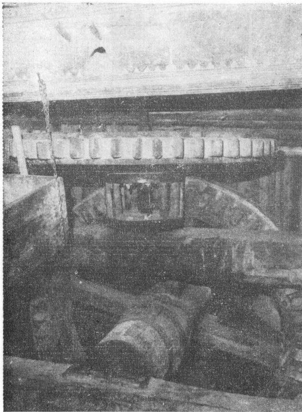
Figura 6 Angrenajul în două trepte al morii hidraulice de la Rogojel, jud. Cluj
