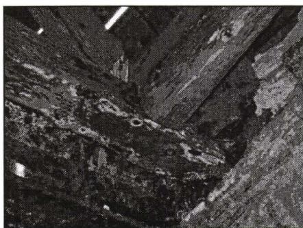
Fig. 1. Castelul din Sâmbăta de Jos, atac de *Coniophora puteana* la elementele planșeului și șarpantei.
