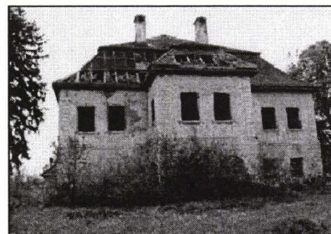
Fig. 2 Castelul din Sâmbăta de Jos, cu învelitoarea de protecție provizorie degradată și infiltrări masive de ape pluviale.
