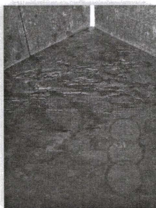
Detaliu - degradare suport interior - aspectul lemnului este îmbătrânit, pătat, având culoarea maroniu închis
