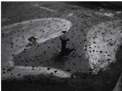
Fig. 4 Detaliu – unul dintre cuiile metalice cu care au fost fixate traversele
