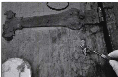
Chituire realizată în interiorul capacului
