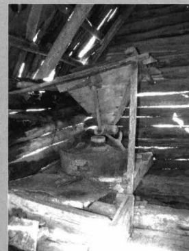
Foto 11 - instalația de măcinat Photo 11 - grinding mechanism
