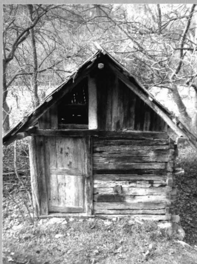
Foto 13 - vedere generală Photo 13 - overall view
