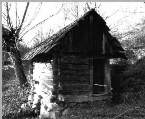
Foto 15 - vedere generală Photo 15 - overall view
