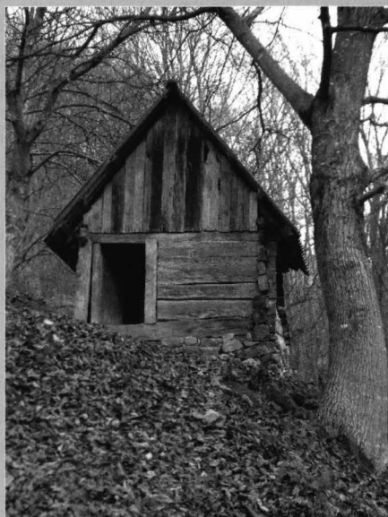
Foto 27 - vedere generală Photo 27 - overall view
