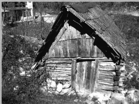
Foto 9 - vedere frontală Photo 9 - front view
