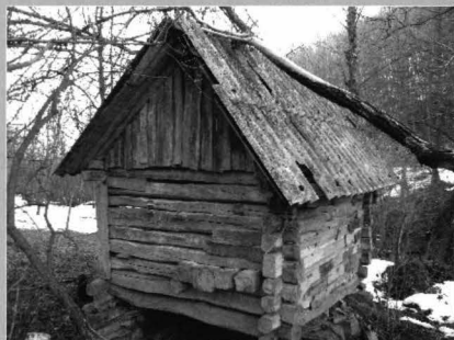
Foto 20 - vedere generală Photo 20 - overall view
