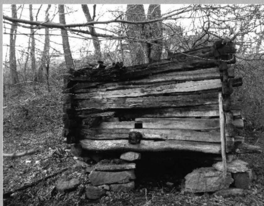
Foto 18 - vedere generală Photo 18 - overall view
