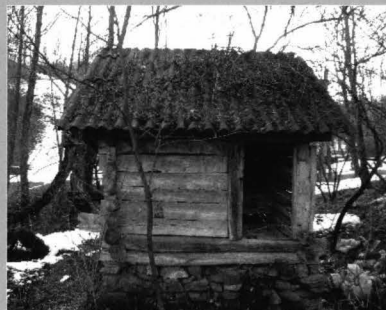
Foto 21 - vedere frontală Photo 21 - front view
