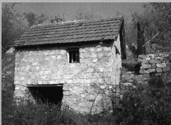
Foto 5 - vedere frontală Photo 5 - front view
