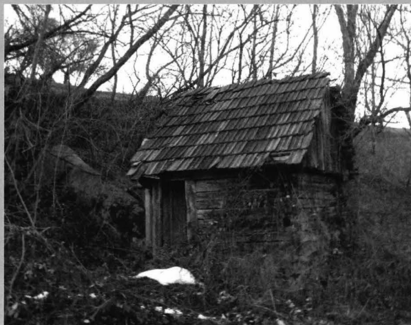
Foto 23 - vedere generală Photo 23 - overall view
