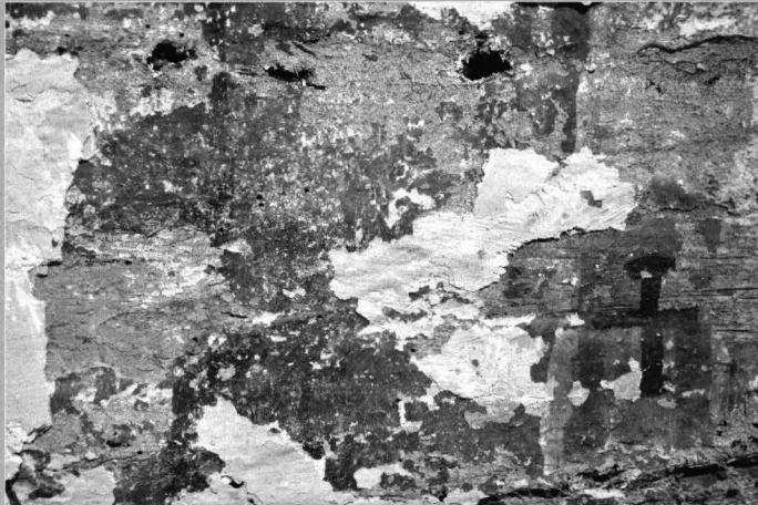
Foto 11 - Biserica de lemn din Runcu Salvei, altar, partea inferioară a pereților, straturi succesive de varuială aplicate peste pictură.
