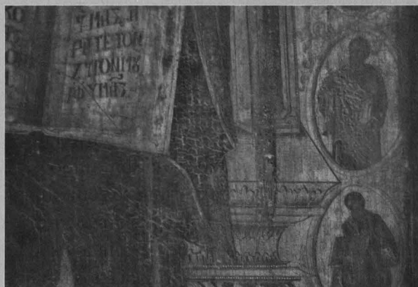
Fig. 7 - Cracluri timpurii și carbonizare Fig. 7 - Early cracks and carbonization
