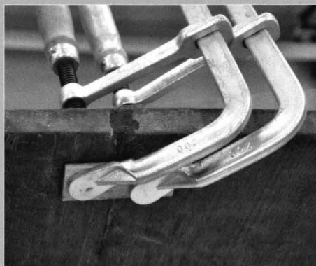
Fig. 10 - Detaliu în timpul consolidării îmbinării
